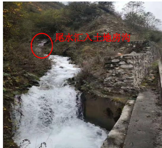
土地房沟与榆磨路交汇处
