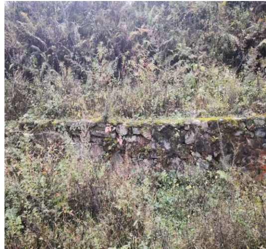
渣场挡墙及植被恢复
