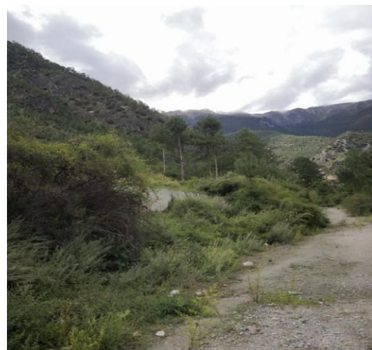
引水明渠施工迹地植被恢复 1
