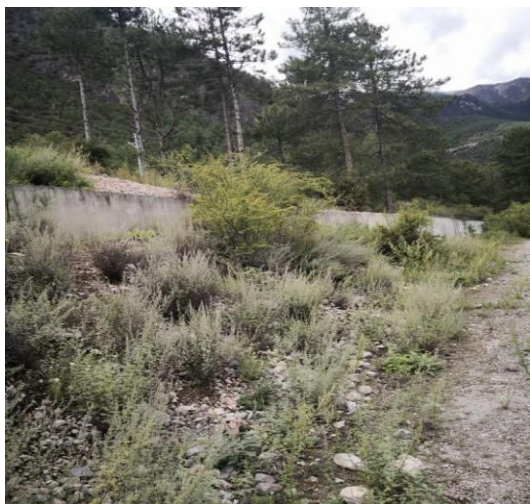
引水明渠施工迹地植被恢复 2
