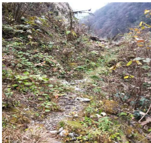
引水渠施工迹地植被恢复 2
