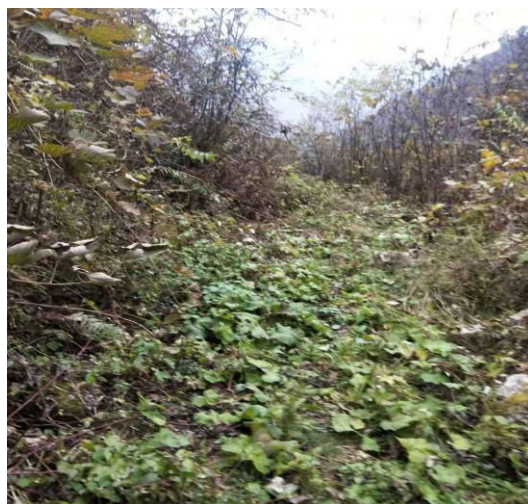
引水渠施工迹地植被恢复 1
