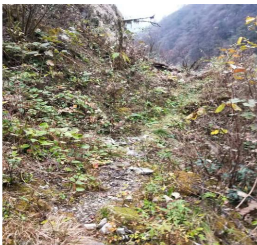
引水渠施工迹地植被恢复 2
